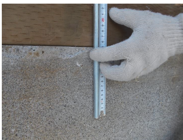
アンカー施工穿孔長 110 mm以上
