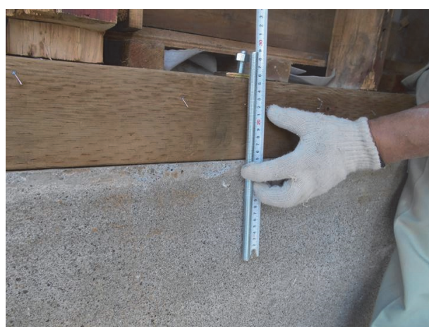
アンカー施工穿孔長 110 mm以上
