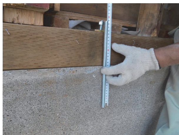
アンカー施工穿孔長 110 mm以上
