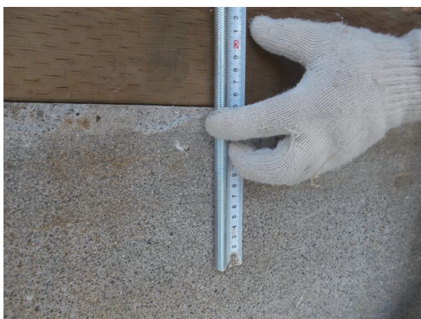
アンカー施工穿孔長 110 mm以上
