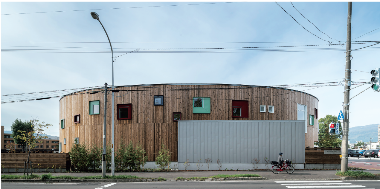
東側立面（前面道路新川通りより）
