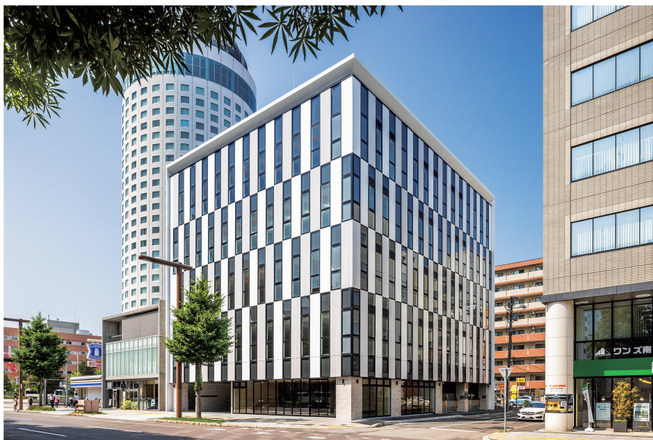
外観（北東側・昼景）
