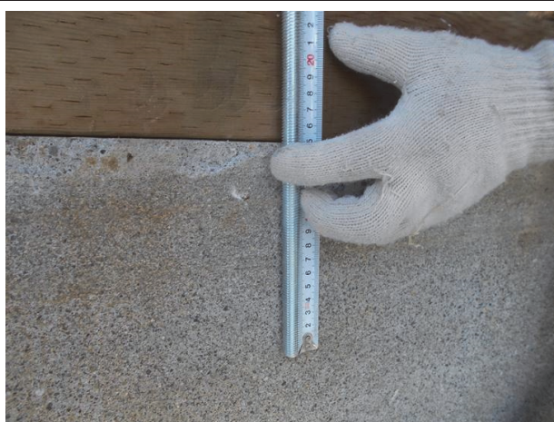
アンカー施工穿孔長 110 mm以上
