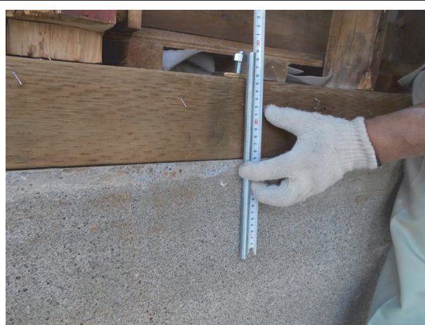
アンカー施工穿孔長 110 mm以上
